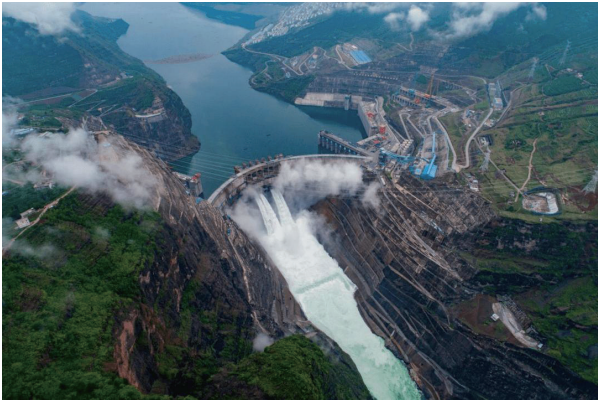
白鹤滩水电站特高压工程
