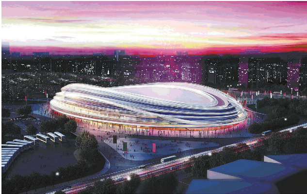
北京冬奥会高效节能配电项目
