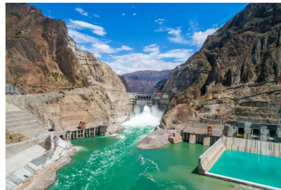
三峡乌东德水电站
