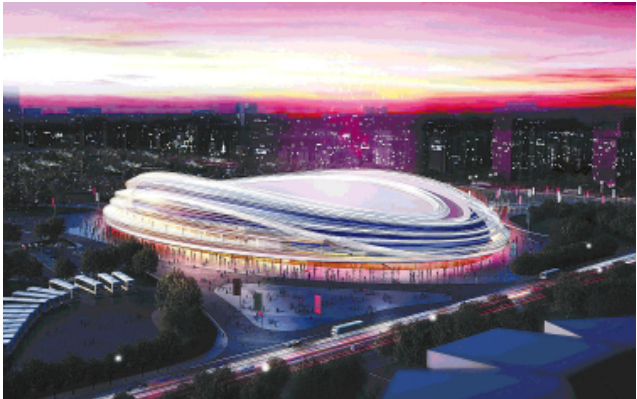
北京冬奥会高效节能配电项目
